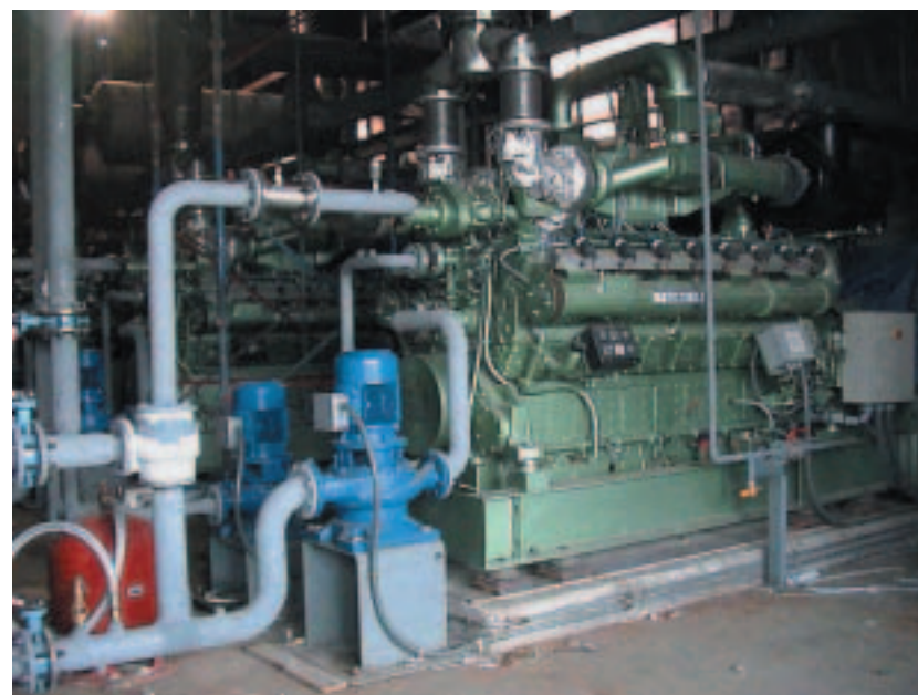
Un impianto per trasformare la sansa delle olive in energia elettrica
